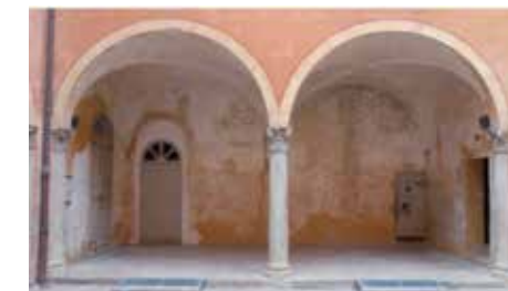
Loggia delle Prigioni prima del restauro
